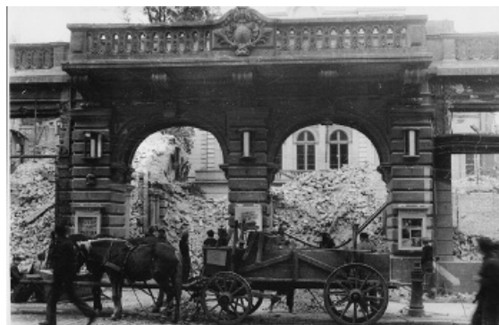
Figure 9. The remains of destroyed front houses – the ruins of the passages that once led to the Theatre court. (from Jakimiec J. red.), Teatr Polski w Poznaniu 1875-1975 , Krajowa Agencja Wydawnicza RSW „Prasa-Książka-Ruch” Oddział w Poznaniu, Poznań 1975
